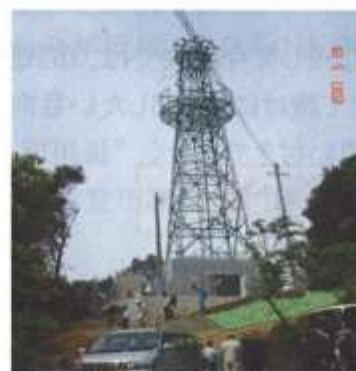
総務委員会市内視察(5月29日) (小笠山に完成した防災無線中継所)
