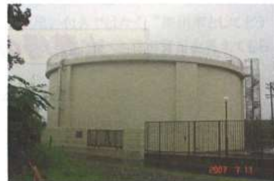
遊家の配水池(容量3,600トン) (次ページ水道決算をご覧ください)
