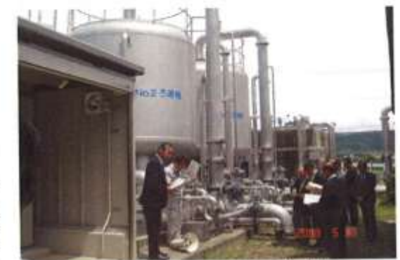
現地視察(5月30日、原里浄水場)
