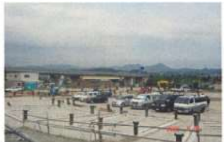
建設中の(仮称)中央幼保園 (20年9月)
