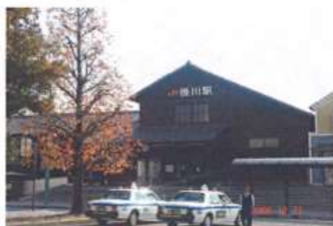
掛川駅北口駅舎(12月21日)
